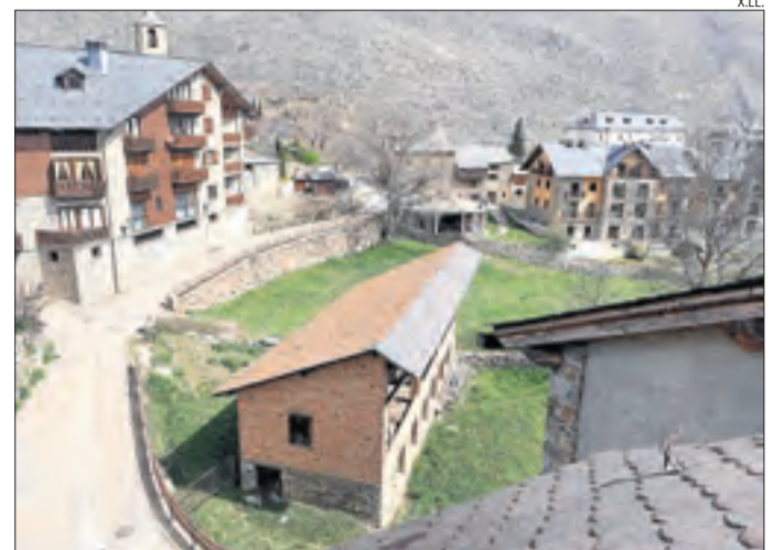
La zona on s'instal·larà la fibra i milloraran serveis.
