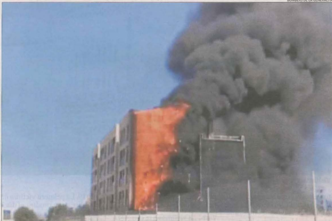
Les flames van calcinar l'aïllant de la façana exterior i van generar una gran columna de fum.
