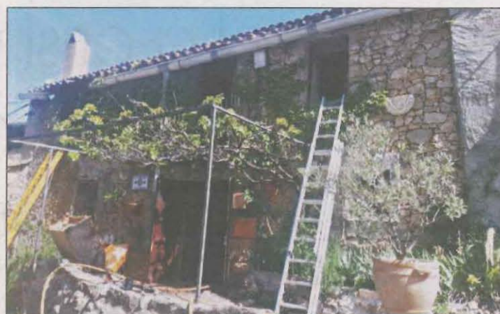
FOTO: Bombers / La casa d'Alsamora afectada per l'incendi
